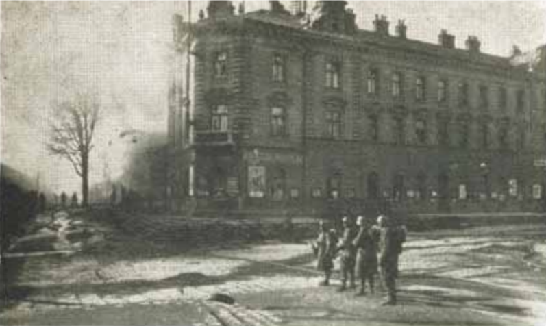
Das Floridsdorfer Arbeiterheim in der Angerer Straße nach den Kämpfen
