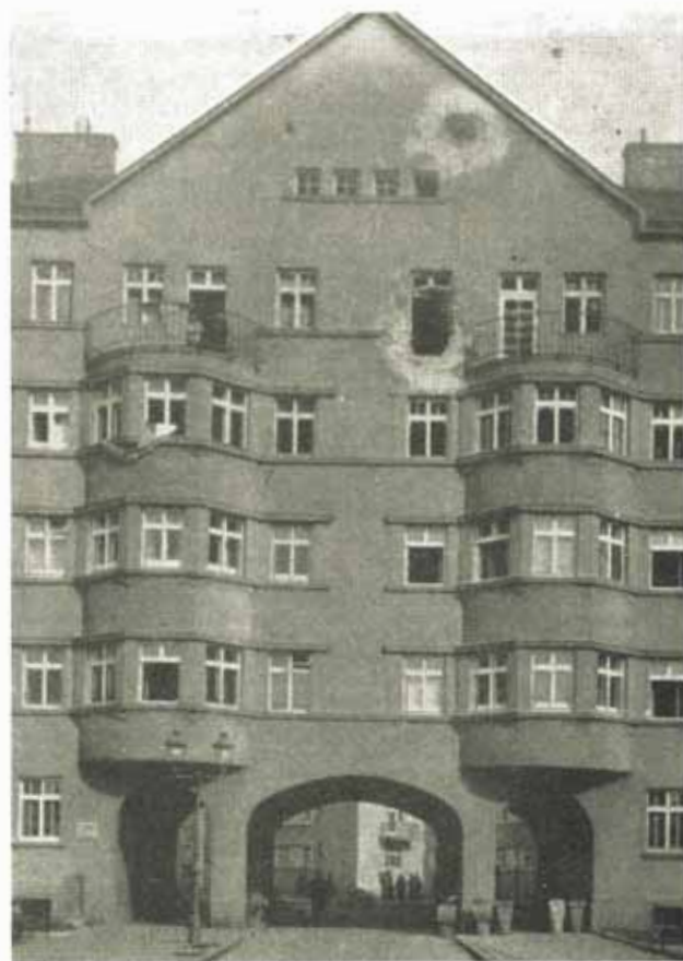
Schwere Artillerietreffer im FAC-Hof, Wien XXI
