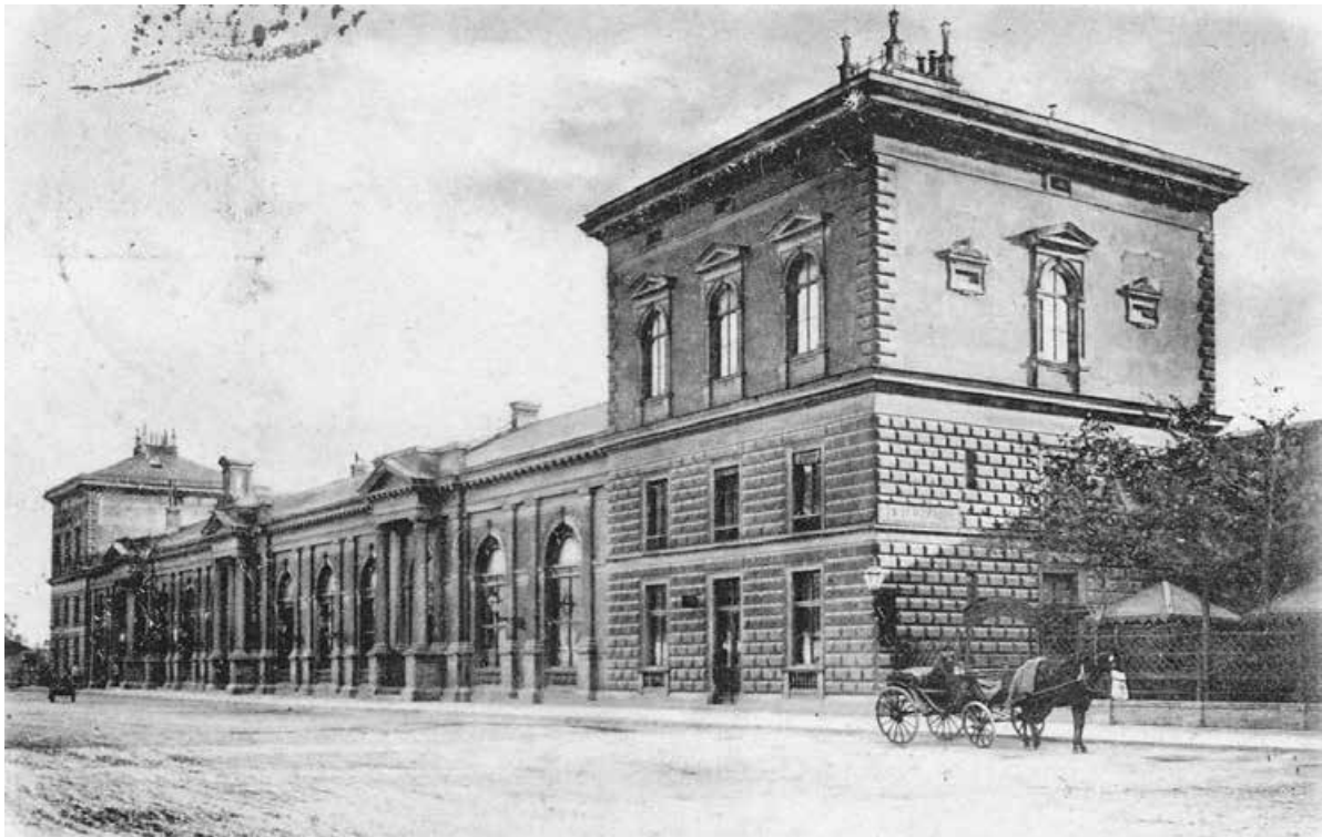
Der Aspernbahn in Wien-Landstraße (1971 geschlossen)
